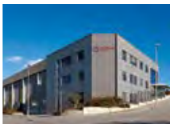
● Výrobní závod Torelló (Španělsko)
