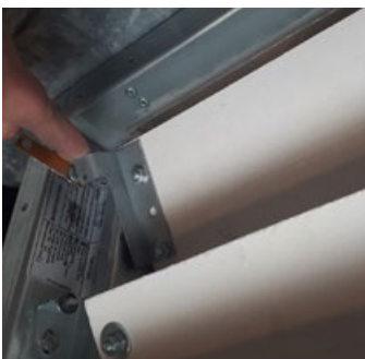
obrázek č. 11 – detail tepelné tavné pojistky u žaluziové klapy a jednotlivé polohy listu při aktivaci
