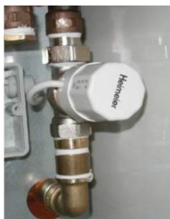
obrázek zabudovaného elektrotermického ventilu
