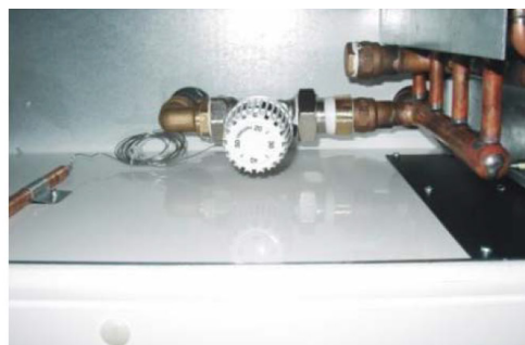
obrázek zabudovaného termostatického ventilu
